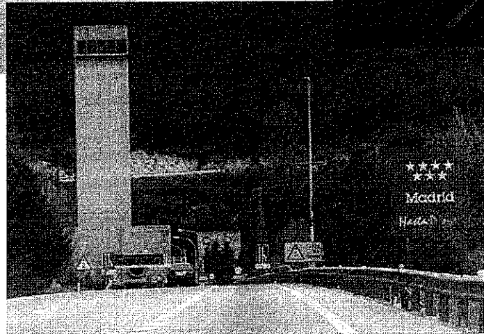
BOCA SUR TÚNEL 2
